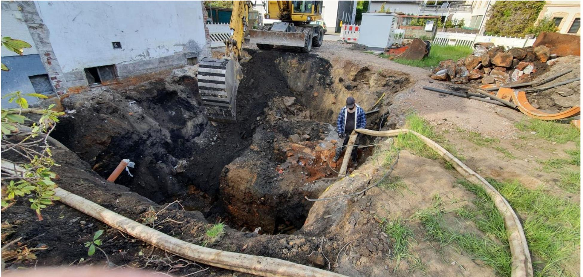
Durch das Freilegen der undokumentierten zweiten Schachtröhre, musste die Planung kurzfristig angepasst werden.
